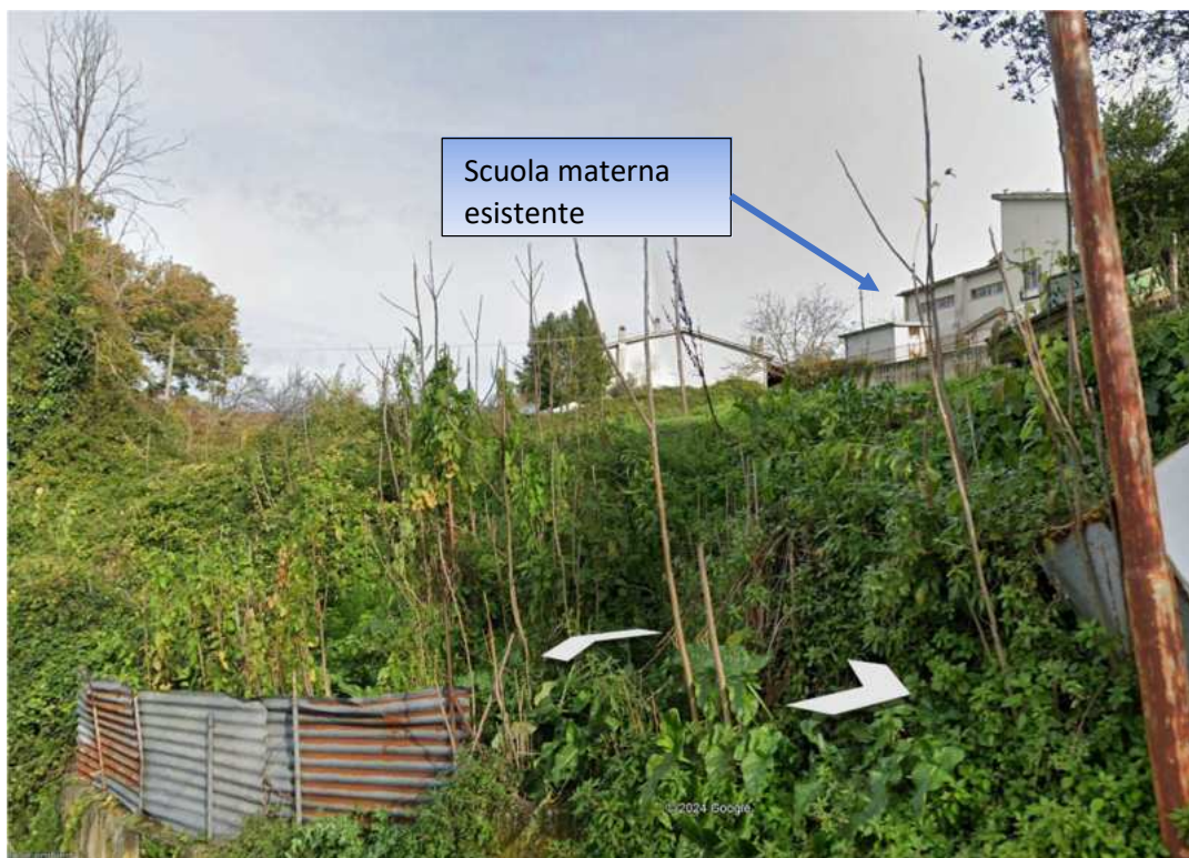
Foto 6 - Vista del lotto dalla strada sottostante Via dei Garofi
